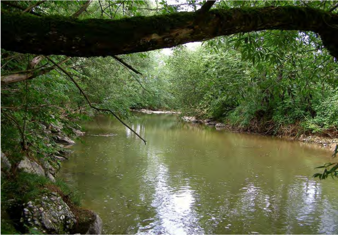
Blick die Leiblach flussabwärts bei Leonards mit Blockwurf-Uferverbauung.
