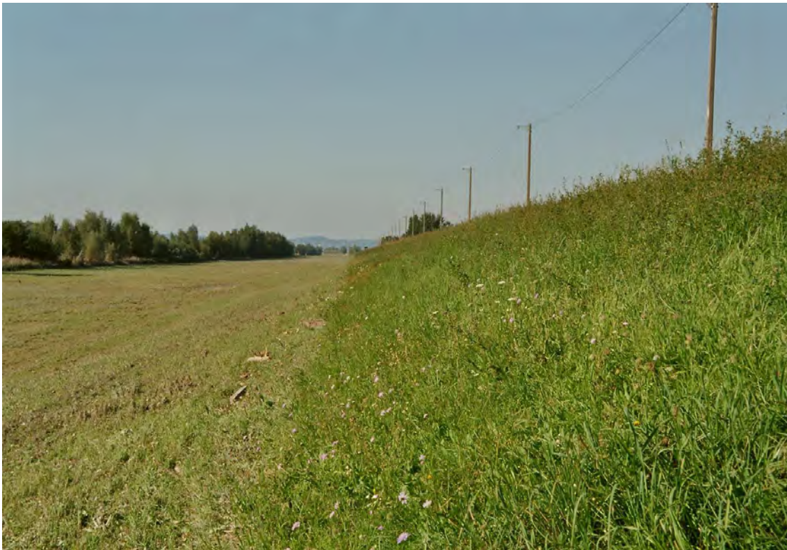
Glatthaferwiesen am Rheindamm.
